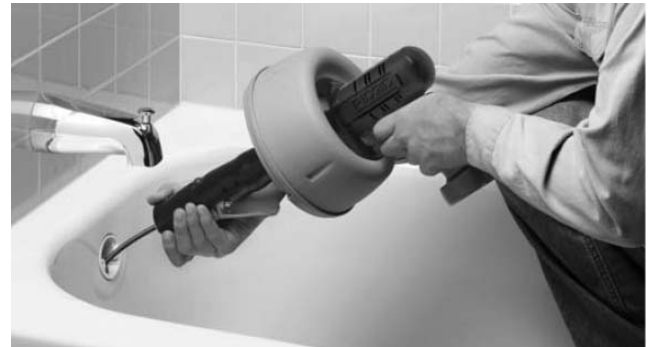
Figuur 5 – Houd afstand tussen afvoeropening en neus van ontstoppingsmachine tot 15 cm of minder
