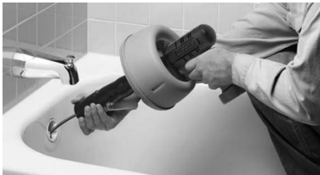
Slika 5 - Ostavite razmak između otvora odvoda i vrha stroja za čišćenje do 6" (15 cm) ili manje
